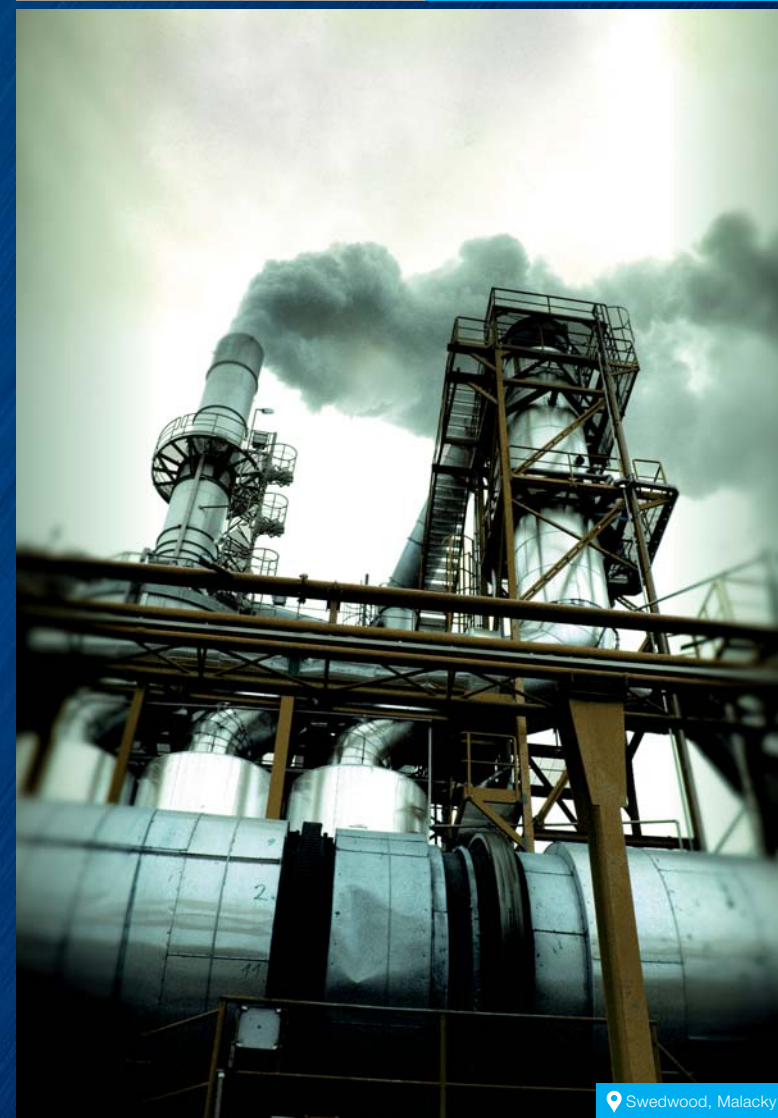
Tepelná elektrárň Planta Centro, Venezuela
