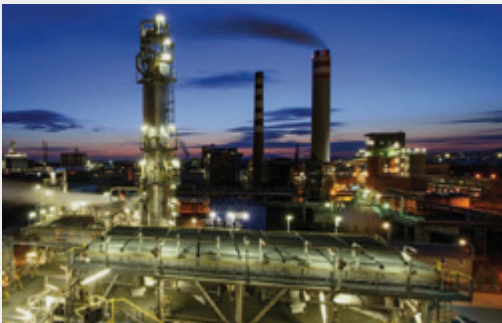
Slovnaft Bratislava, prečerpávacia stanica OVZ
