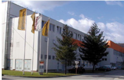
Administratívna budova Continental Matador v Púchove
