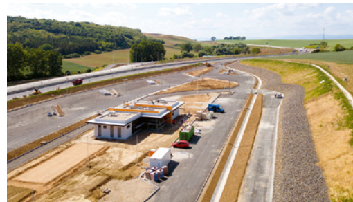
Odpočívadlo na rýchlostnej ceste R4 Košice – Milhost'
