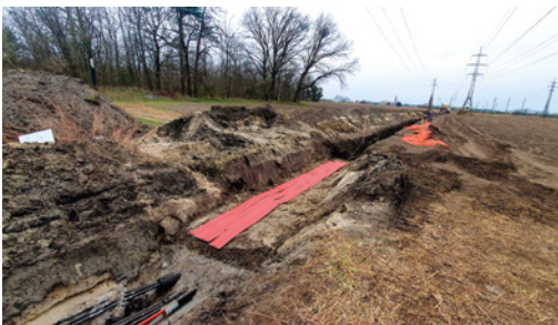
Výkopové práce a pokládka VN kábla – ES Stupava ES Malacky
