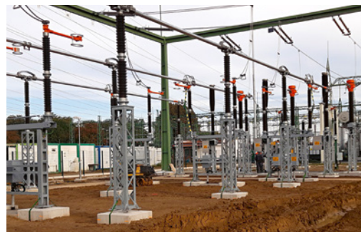
Výstavba ES 245 kV Opočínok
