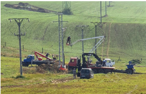
Modernizácia distribučnej siete obec Prietrž
